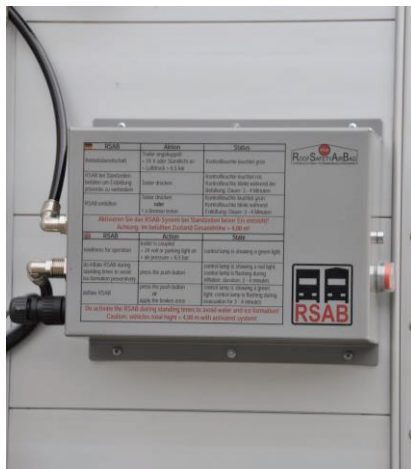
RSAB-Steuereinheit fertig montiert
