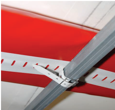
RSAB Lochband unten mit Lederschnalle und Spriegel
