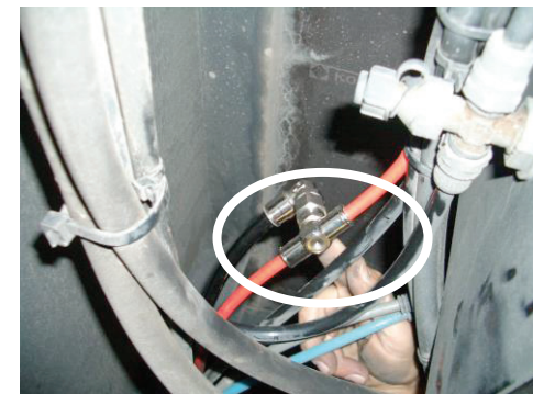
Überströmventil mit Anschluss T-Stück, Luftleitung 8/8 auf 3/8 Zoll, Muffe, Winkelverschraubung Ø12-3/8" für Versorgungsleitung.
