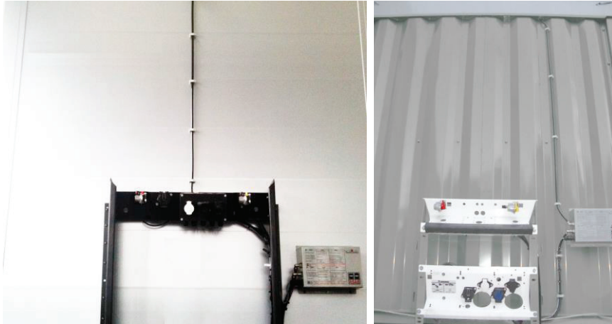
Steuereinheit mit Steuerleitung (12x9) an der Stirnwand (Leitung kann sowohl mittig, als auch lotrecht an der an der Steuereinheit verlegt werden)
